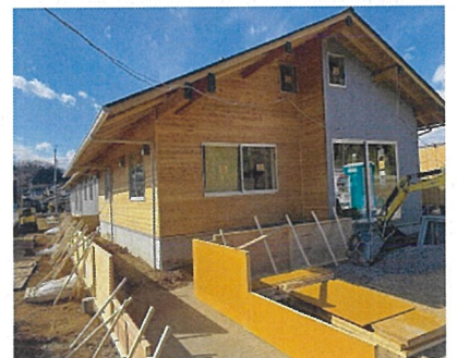
2月7日 スロープコンクリ打設
