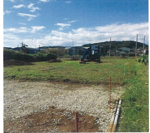
10月初旬 地盤整備
