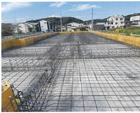
11月16日 基礎工事
