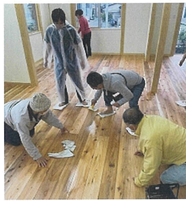
3月19日 メンバーによる床の油性塗料塗り
